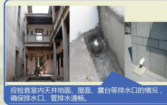
应检查室内天井地面、屋面、露台等排水口的情况，确保排水口、管排水通畅。
