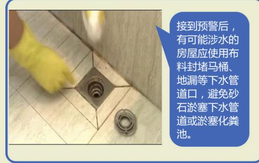
接到预警后，有可能涉水的房屋应使用布料封堵马桶、地漏等下水管道口，避免砂石淤塞下水管道或淤塞化粪池。
