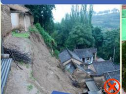
应避开削坡填坡形成的台地上,或未加支护的不合理削坡的下方,无法避开的应有边坡支护。
