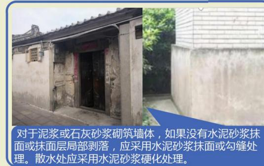
对于泥浆或石灰砂浆砌筑墙体，如果没有水泥砂浆抹面或抹面层局部剥落，应采用水泥砂浆抹面或勾缝处理。散水处应采用水泥砂浆硬化处理。
