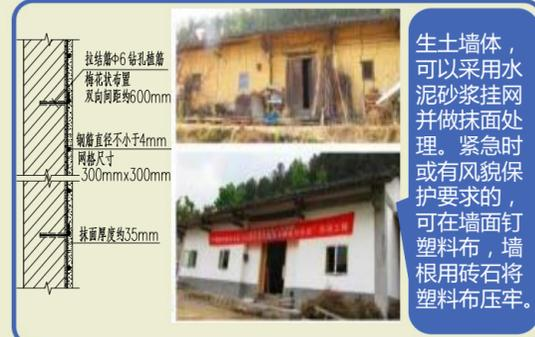
生土墙体，可以采用水泥砂浆挂网并做抹面处理。紧急时或有风貌保护要求的，可在墙面钉塑料布，墙根用砖石将塑料布压牢。
