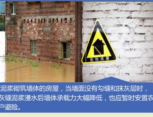
泥浆砌筑墙体的房屋，当墙面没有勾缝和抹灰层时，灰缝泥浆浸水后墙体承载力大幅降低，也应暂时安置农户避险。
