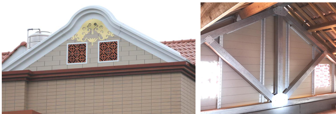
图 3.6-1 铝合金型材组合轻质围护墙案例
