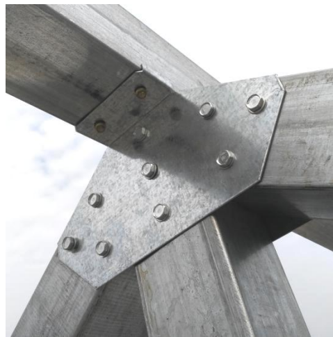
钢屋架螺栓节点连接二
