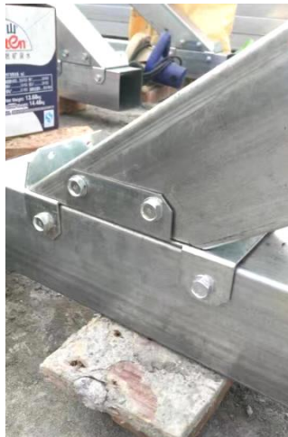
钢屋架螺栓节点连接一
