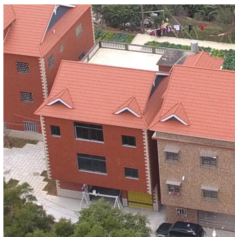
(d) 坡屋面老虎窗（门）位置与原建筑的窗或阳台相对应
