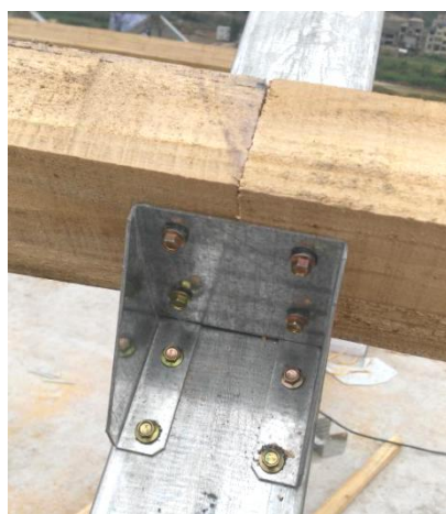
方木檩条与钢屋架螺栓节点连接
