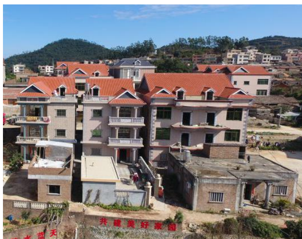
(d) 坡屋面老虎窗（门）位置与原建筑的窗或阳台相对应
