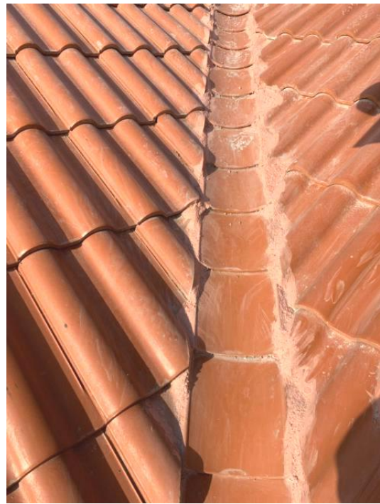
❌沟瓦与坡面瓦等高，填塞水泥砂浆
