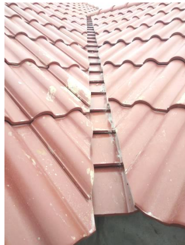
✅正确的斜瓦沟
